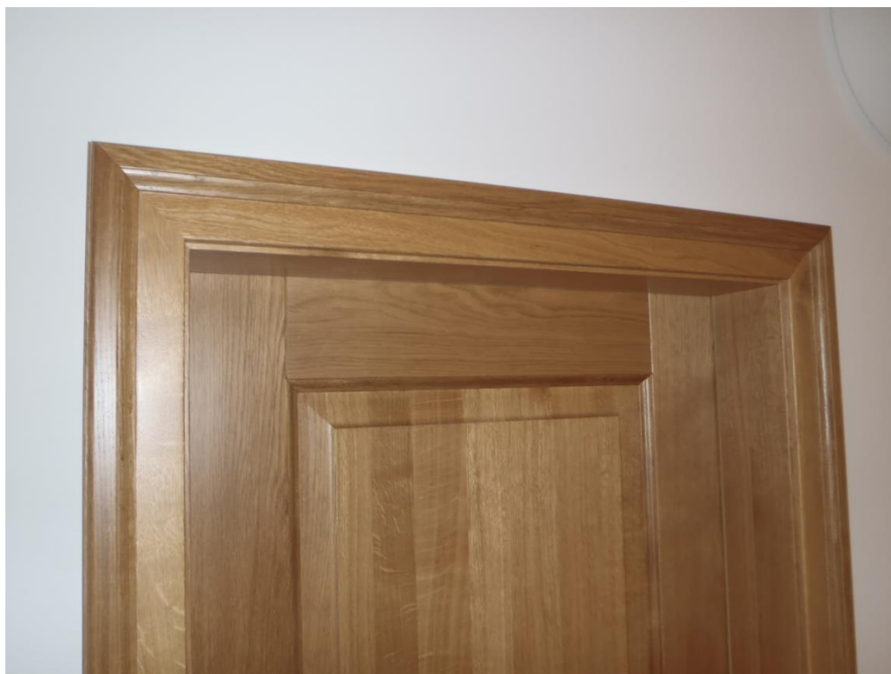
Detail profilace zárubně
