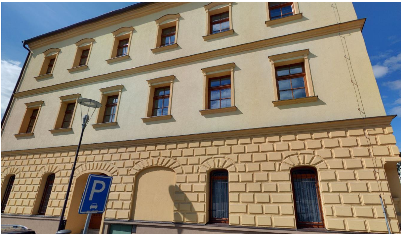
Římsy, bosáže, šambrány, barevnost fasády a oken
